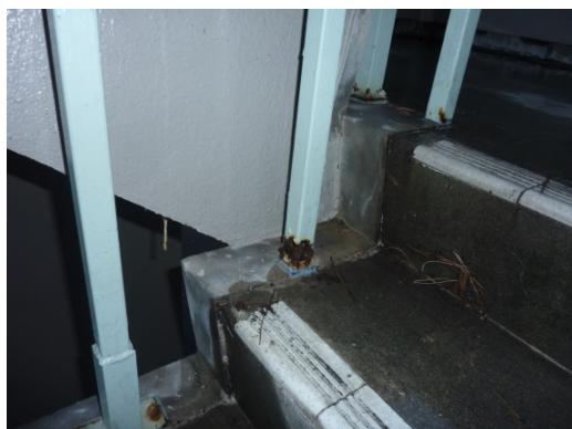
階段手すり鋼材の腐食
