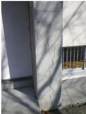
鉄筋コンクリート柱のひび割れ
