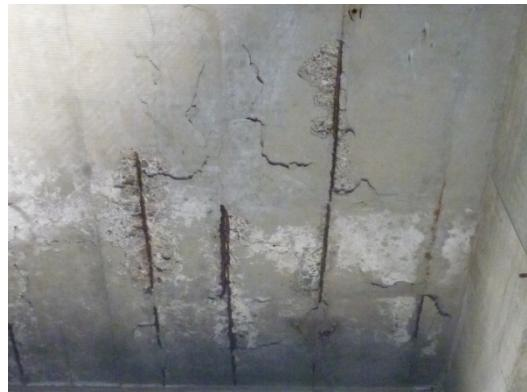
鉄筋コンクリート床下の鉄筋腐食
