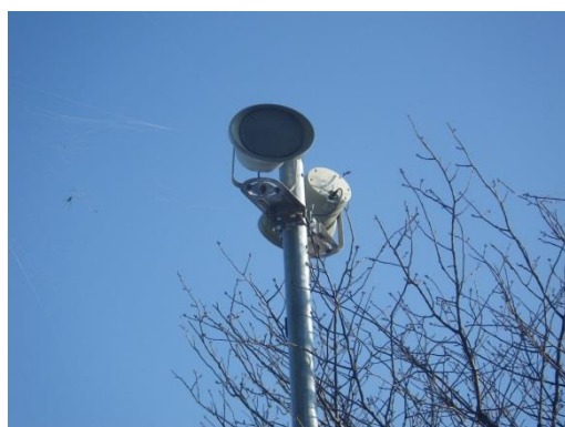
放送設備新設 (参考：物部団地)
