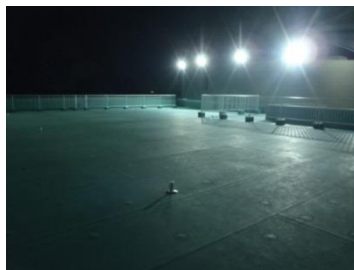
屋上手すり及び照明
