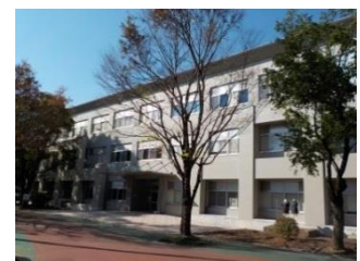
コンクリート製フレームによる耐震補強をデザイン要素とした理学部1号館
