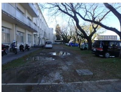
農林海洋学部周辺駐車場の整備
