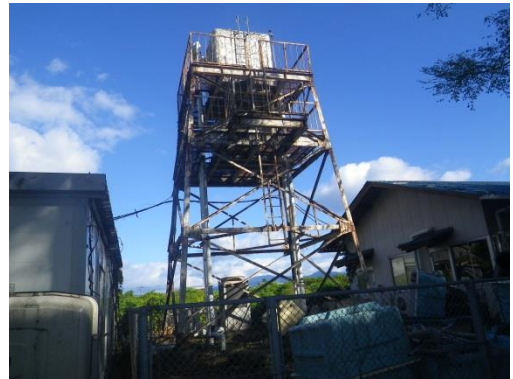
淡水魚飼育室高架水槽現状
