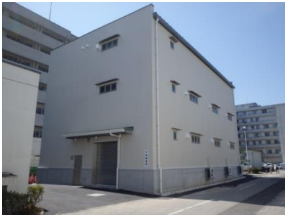
備蓄倉庫(鉄骨造3階建720㎡)
