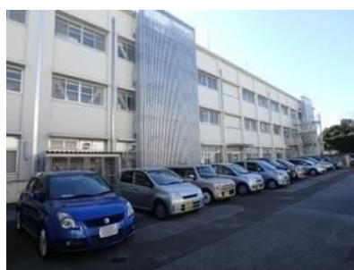
3号館付近の駐車状況
