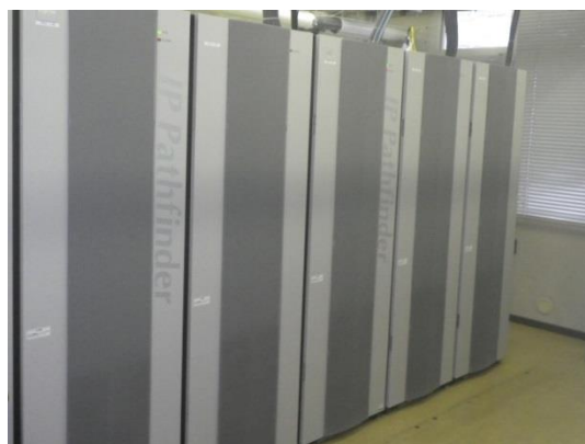
電話交換機設備更新
