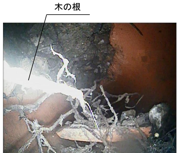
排水配管内現状
