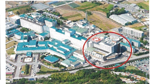
新病棟完成写真
