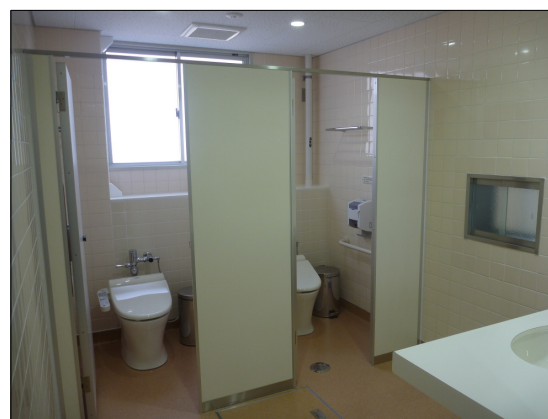
女子トイレ（改修後）
