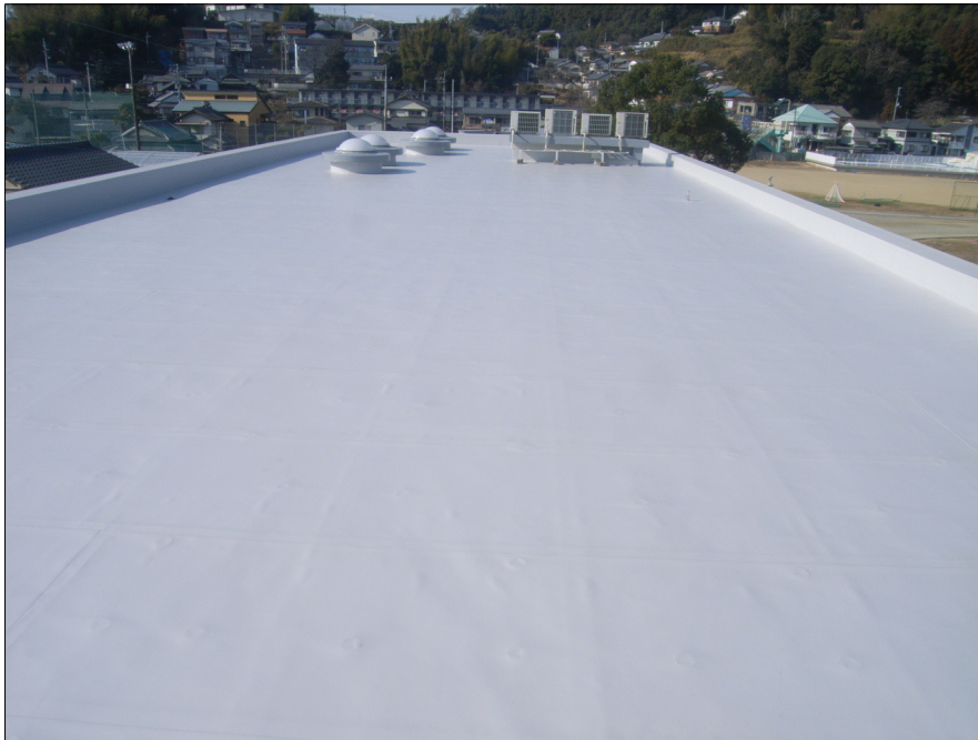
課外活動共用施設3屋上防水（改修後）
