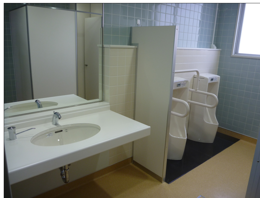
男子トイレ（改修後）
