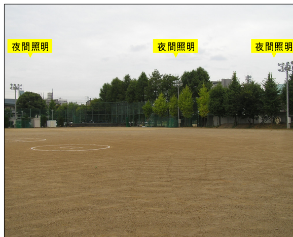
夜間照明設備 （グラウンド8灯-3基、テニスコート4灯-1基）
