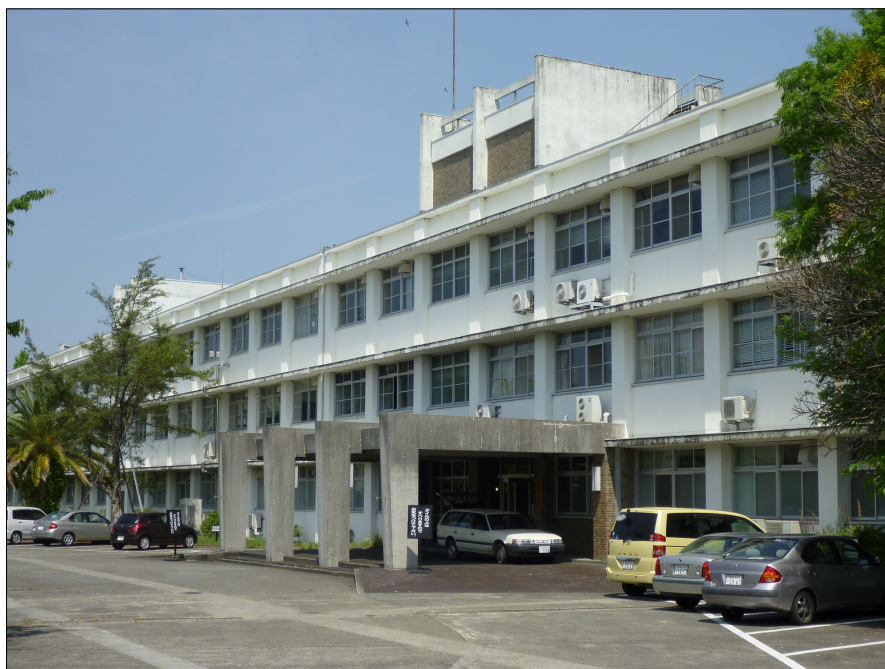
南面外観（改修前）
