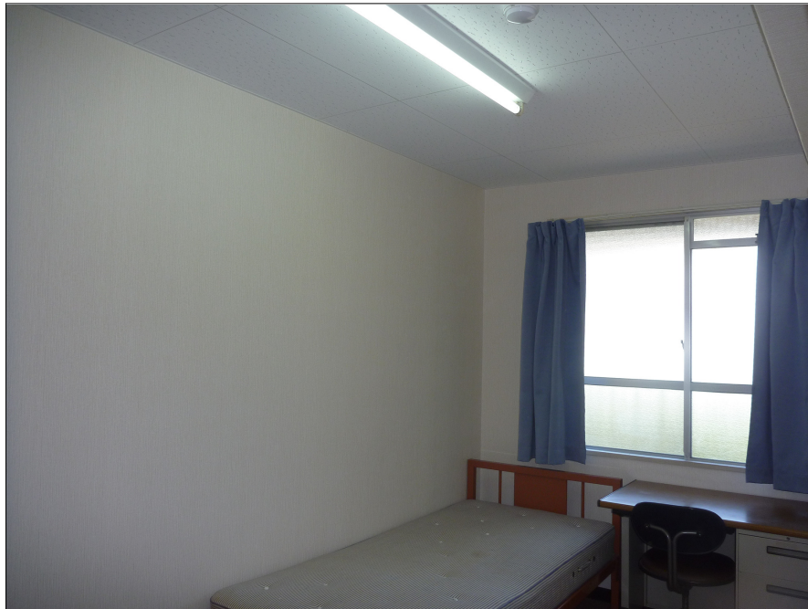
改修後 ↑ 改修前 寮室（改修後） （天井：化粧石膏ボード張り、壁：ビニルクロス張り）
