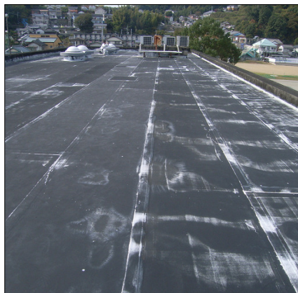
屋上防水（改修前）
