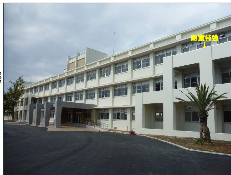
南面外観（改修後）
