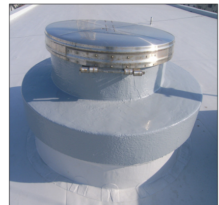
屋上点検孔（改修後）
