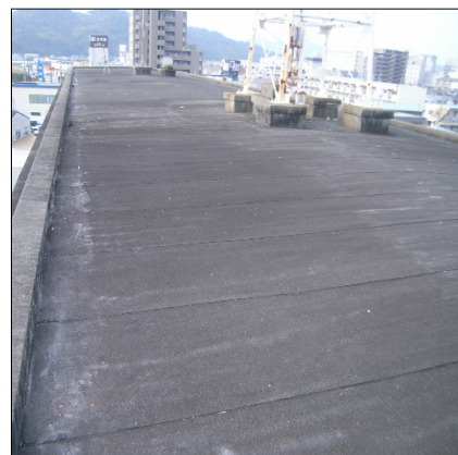
屋上防水（改修前）
