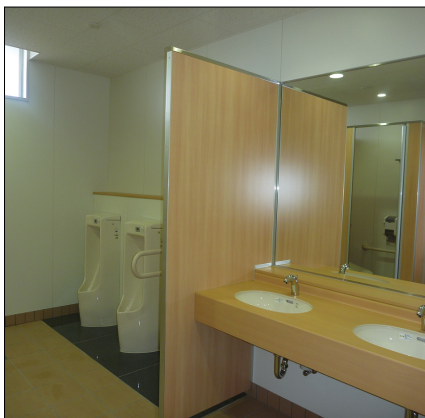
男子トイレ（改修後）
