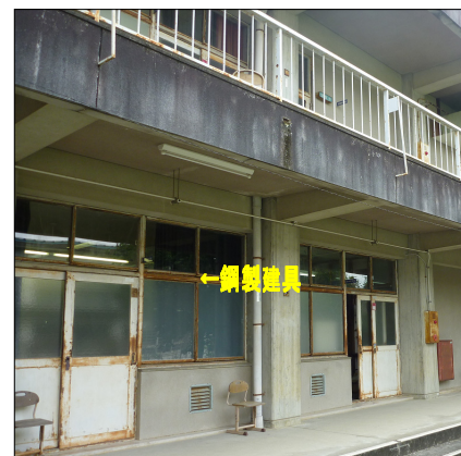
北面建具（改修前）
