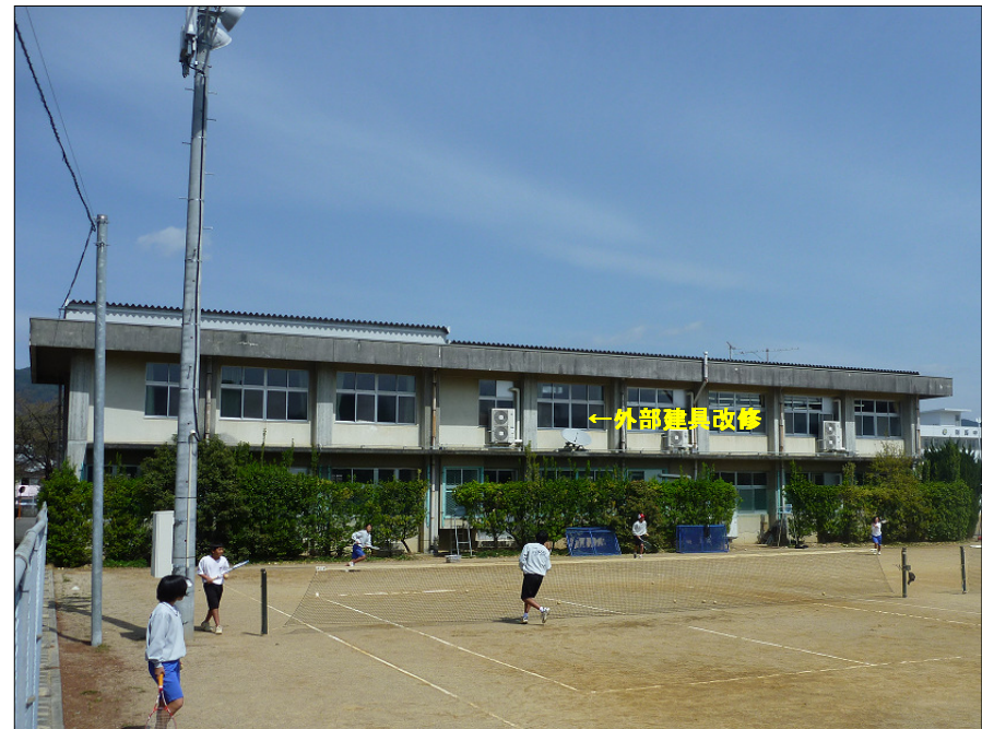
南面外観（改修後） （平成22年度は外部建具改修のみ）
