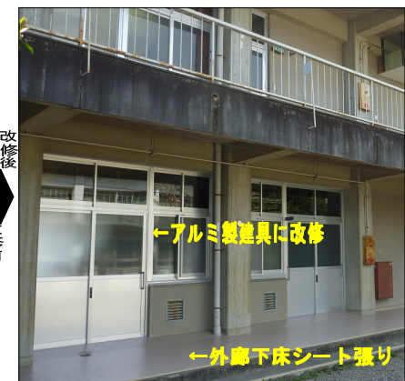
北面建具（改修後）
