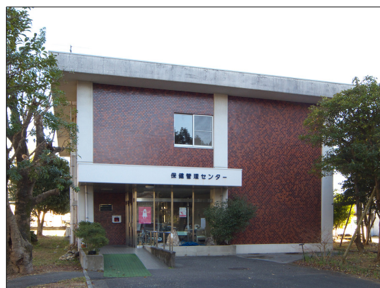
西面外観（改修前）
