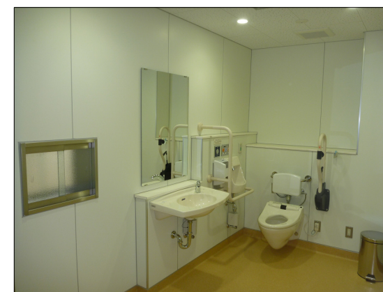
多目的トイレ（改修後）
