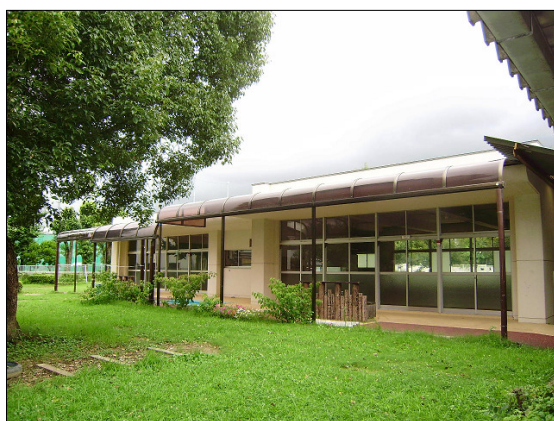
南東面外観（改修前）
