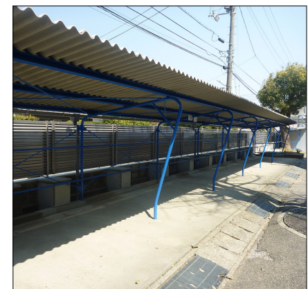
自転車置場改修（改修後） （屋根・塗装改修）
