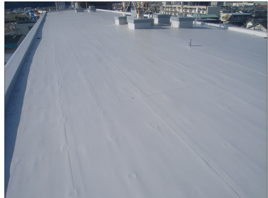
高須職員宿舍屋上防水（改修後）
