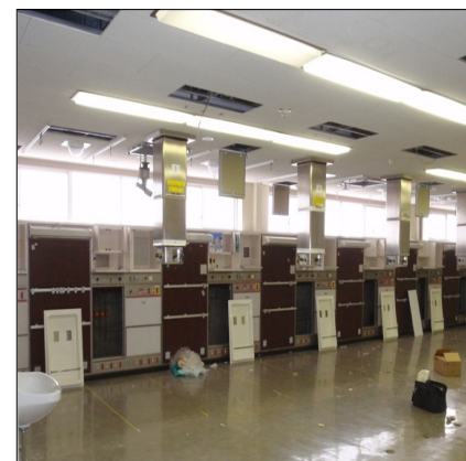
ICU病床（改修前）
